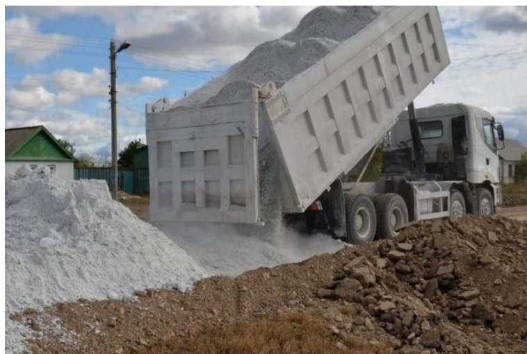
施工现场图片
